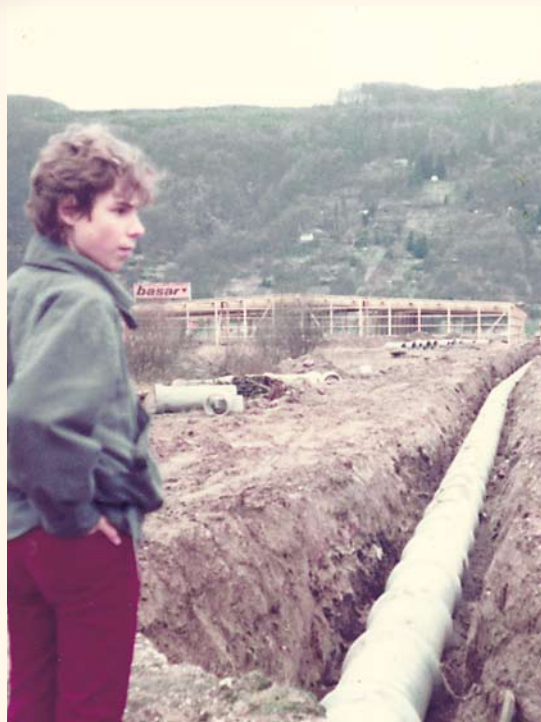
Stefan Leyendecker Bau des Großhandelslagers, 1984
