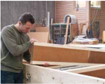
Vorfertigung von Wandelementen mit STEICO LVL R und STEICOWall.
