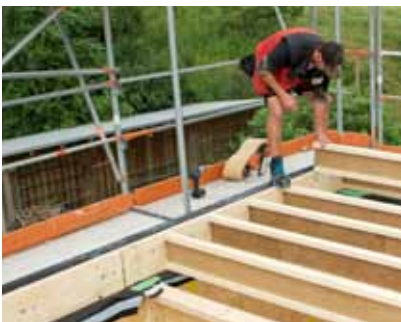
Als setzungssichere Randbohle (in Kombination mit STEICOjoist)
