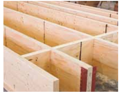
Vorfertigung von Hohlkasten-Deckenelementen.
