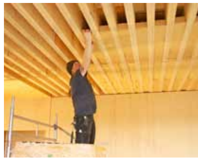
Weit spannende Deckenkonstruktionen im Objekt- und Gewerbebau
