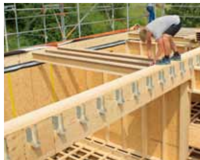
Als Hauptträger (Stahlersatz)
