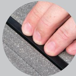
Kleinere Abstände in der Fuge reduzieren sich durch das Breitenwachstum der Dielen.
