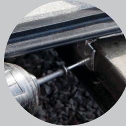
Klammern mit den mitgelieferten Schrauben am Konstruktionsbalken fixieren. Schraube nicht festziehen.
