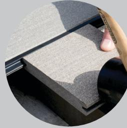
Falls notwendig, im Bereich des Clips mit Hilfe des Dielenabschnitts die Nutleiste nachsetzen.
