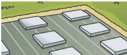
Fundament mit Platten (Abstand ca. 60 cm) auslegen
