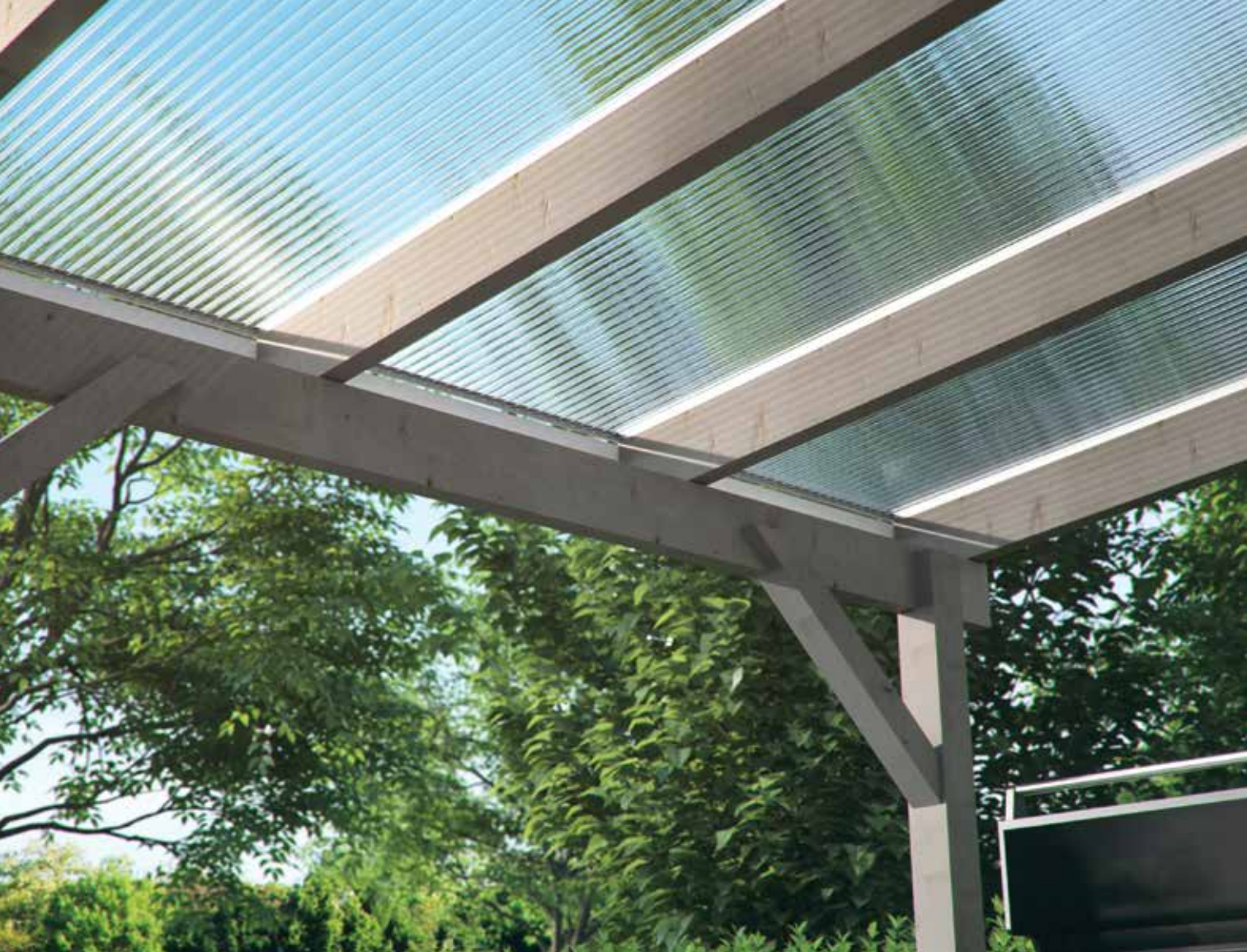
Terrassendach mit höchster Hagelfestigkeit: klare Polycarbonat Stegplatten
