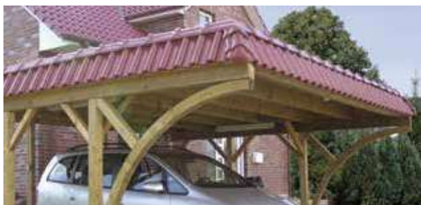
Breite Einfahrt: Pfostenbögen aus Leimholz
