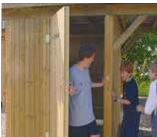
1 Einzeltür, Massivholzrahmen, inklusive verzinkter Beschläge
