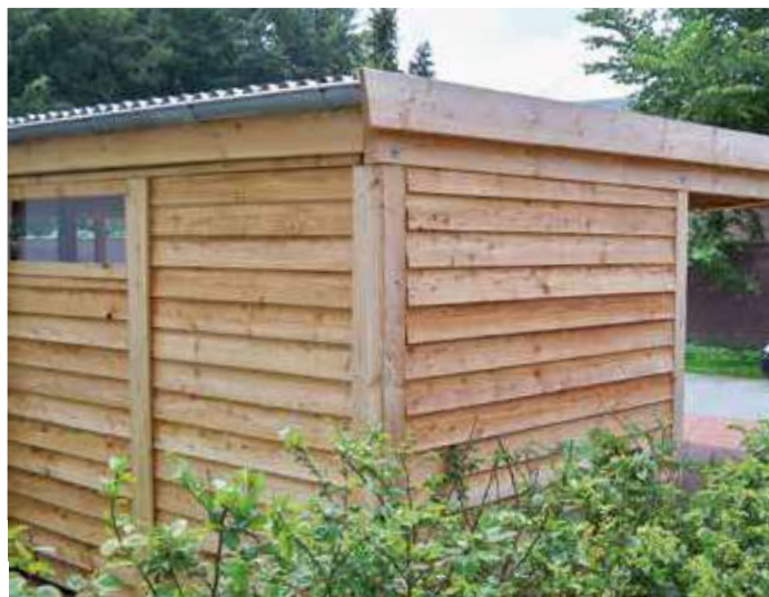
Belastbar: Verkleidung mit rustikalem Fassadenprofil. Abbildung zeigt Natur-Variante aus Lärche
