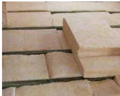
Bei Blindboden, vorbereitet für Dämmung. Machen Sie das Haus von unten winterfest. Aufpreis für kesselhochdruckimprägnierter Blindboden: wird nur bei Erstellung von Streifenfundamenten benötigt, wenn Isomaterial in den Fußboden eingebracht werden soll
